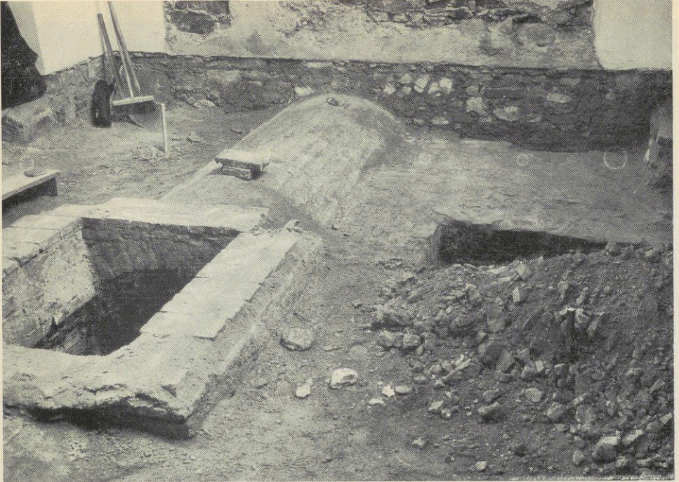
Abb. 6: Benediktbeuern. Einblick in die südliche Gruft der Klosterkirche gegen Westen Öffnung und Gewölbe des Mittelflures gegen Westen gesehen. Aufnahme Januar 1969.
