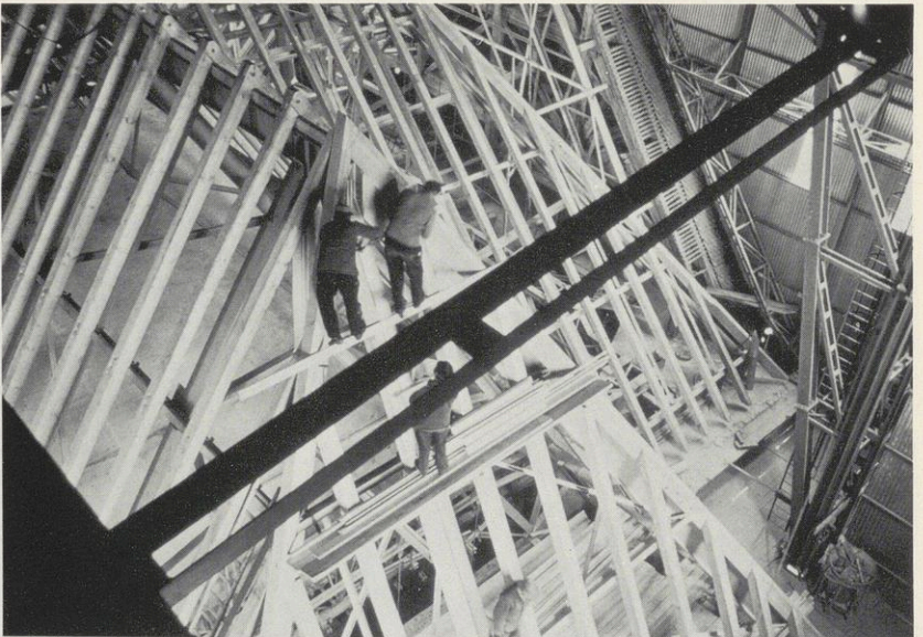
Der Stahldachstuhl im Vierungsbereich und die auf ihm befestigten Holzsparren
