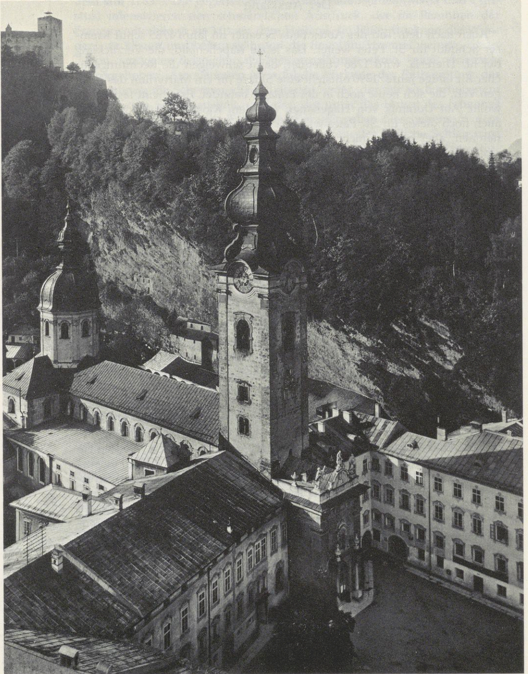
Abb. 101 Gesamtaufnahme vom Turm der Franziskanerkirche. Um 1910 (Foto Hintner, Salzburg)
