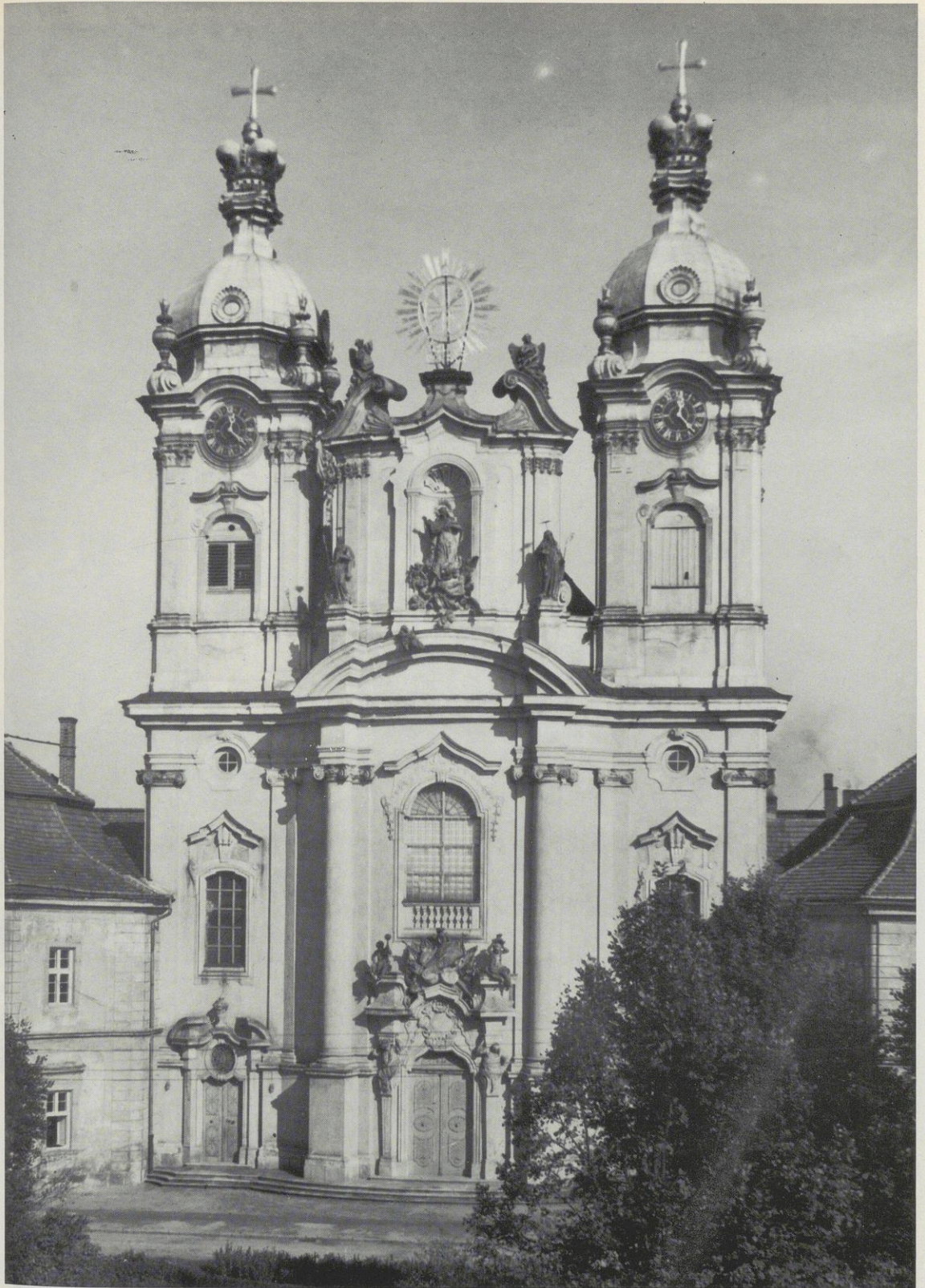
43 Propsteikirche in Wahlstatt, Fassade mit Türmen
