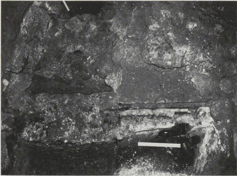
Abb. 22 Kreuzgang, Steinmauer (SM) mit aufgesetzter Rutenputzwand (RP), davor Terrazzo-Estrich (T); dahinter Trennmauer von R 01a/02a von Stratum 3 (3).
