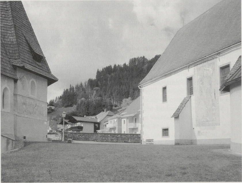
Metnitz, Pfarrkirche St. Leonhard und Karner, Gesamtansicht.
