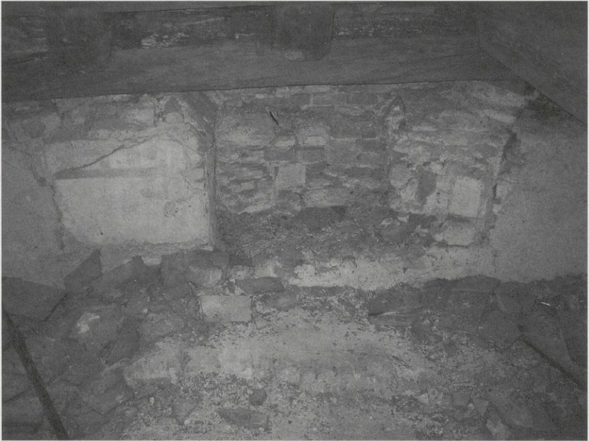
Abb. 2: Langhaus Mittelschiff, Dachboden, Baufuge in der nördlichen Mittelschiffwand
