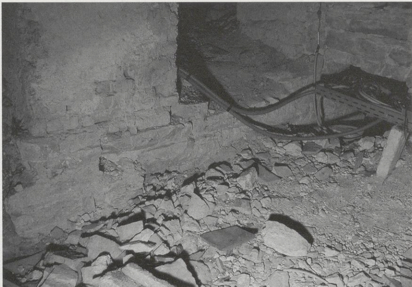
Abb. 6: Bereich Achse 0, Dachboden, ehemalige romanische Quermauer
